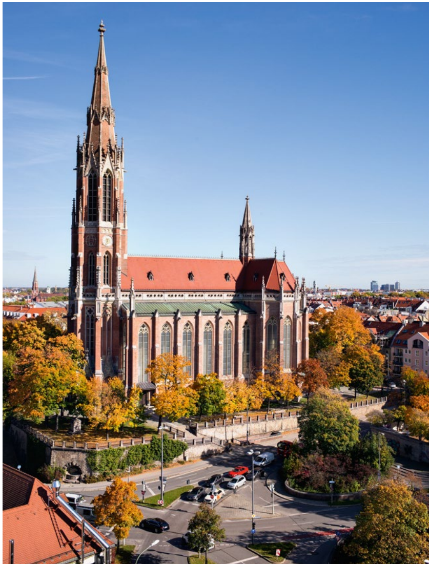
Wahrzeichen des Viertels: Oben auf dem Giesinger Berg thront seit Ende des 19. Jahrhunderts die Heilig-Kreuz-Kirche, die gerade frisch renoviert wurde
